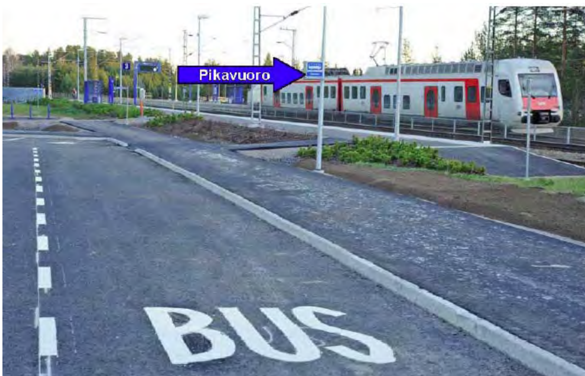
Kuva 3. Uudenkylän henkilöaseman kolmas pikavuoropysäkki pohjoislaiturin vieressä on ollut rakennussuunnitelman mukaisella paikallaan marraskuusta 2011 alkaen. Kaksi muuta pikavuoropysäkkiä sijaitsevat rakennussuunnitelmassa Kouvolantien varressa. Asemalle saapuu taajamajuna H9669 Helsingistä Riihimäen kautta Kouvolaan. Kuva Markku Sakari Meriluoto 2011-11-15.
